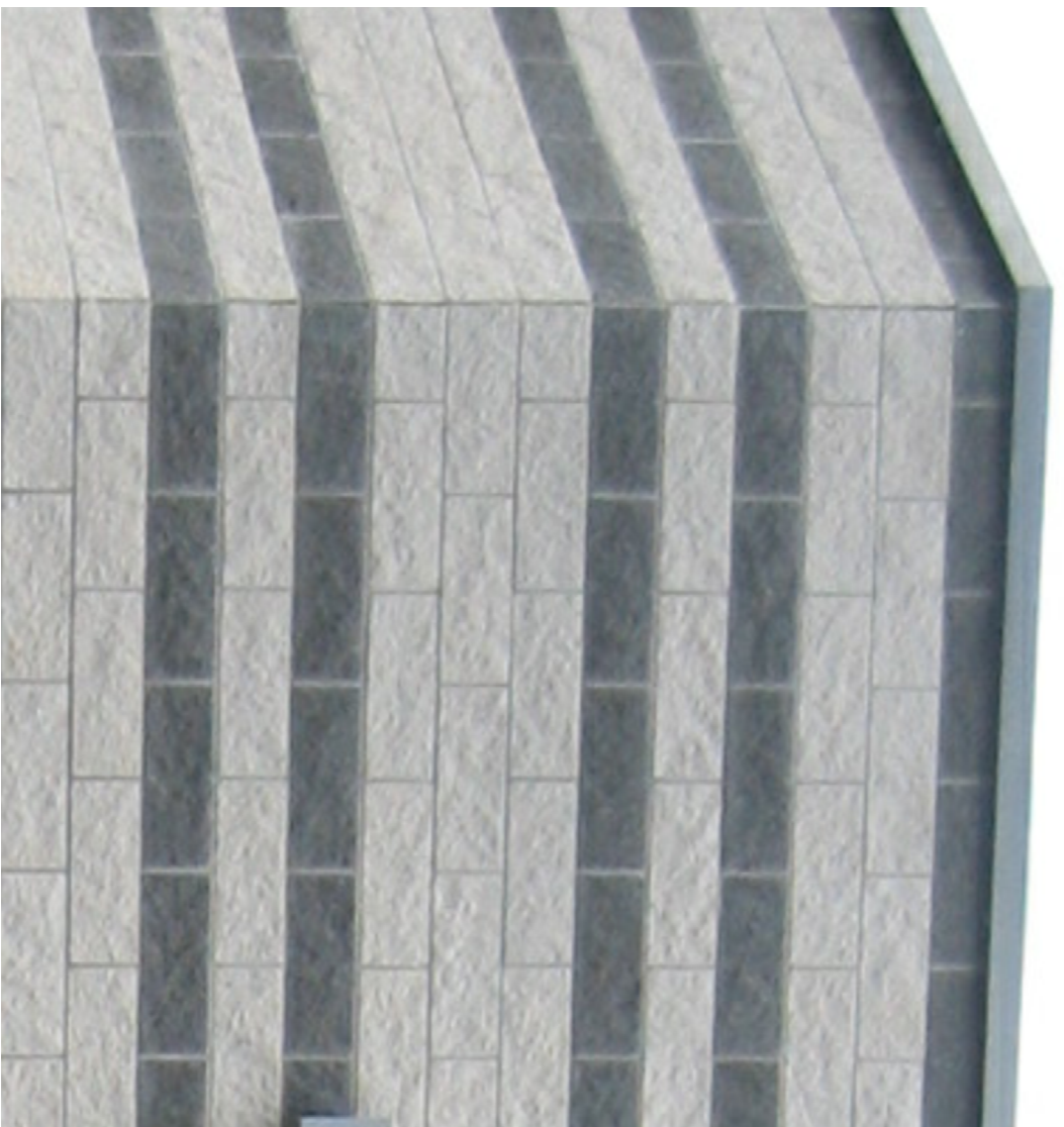
Esempio di facciata con mattoni con blocchi di cemento spillati
